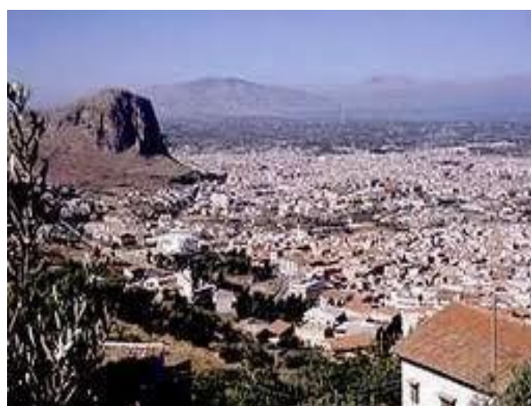
Colle Cesarò (rischio caduta massi, crollo)
