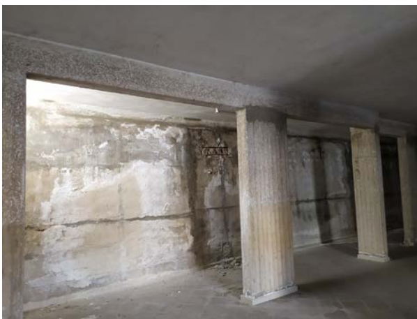
Infiltrazioni ed efflorescenze
