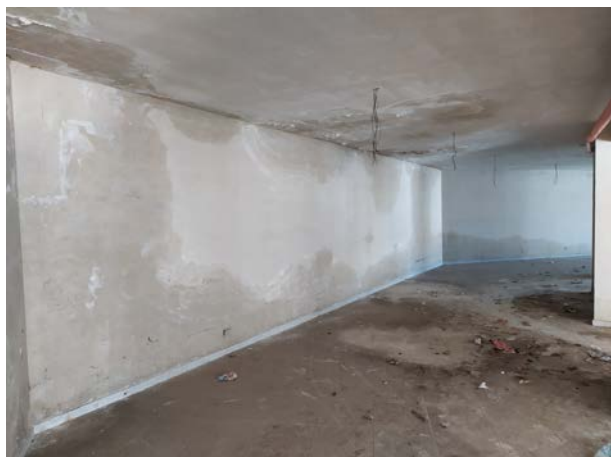
Infiltrazioni ed efflorescenze
