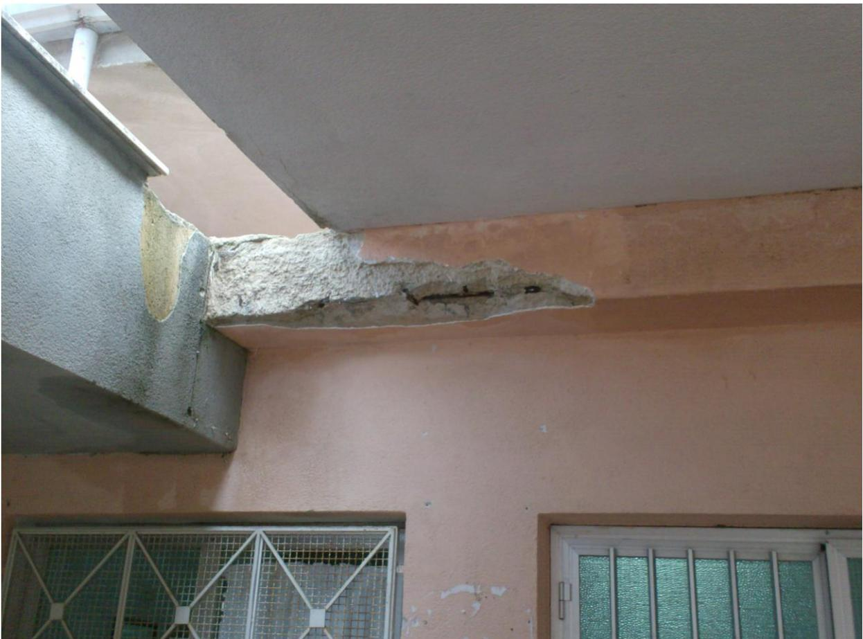
**Foto n. 16 - Intonaco esterno della trave di piano**
