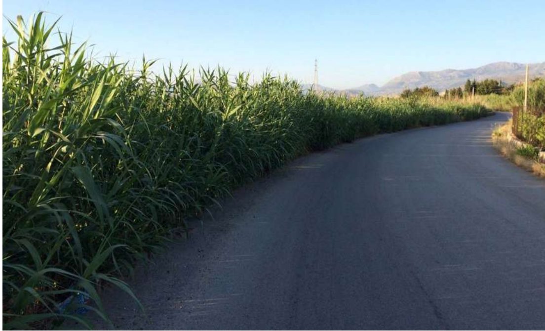
Figura 10 – Vista area interessata dal Confine SE (S.P. n. 39)
